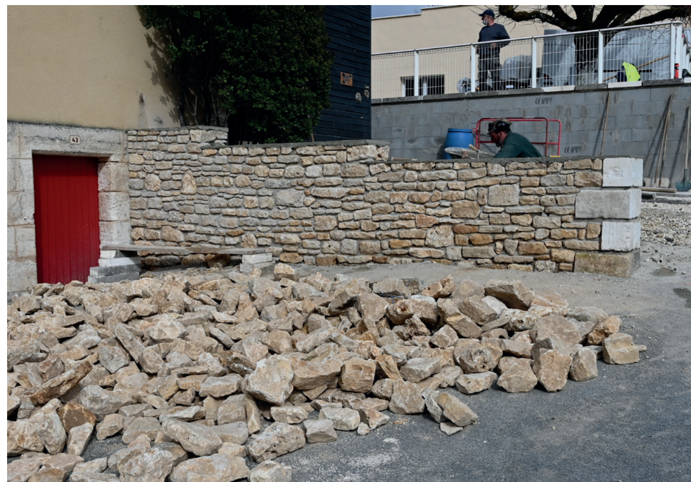
Création d'un muret à Ligeux par les agents communaux
