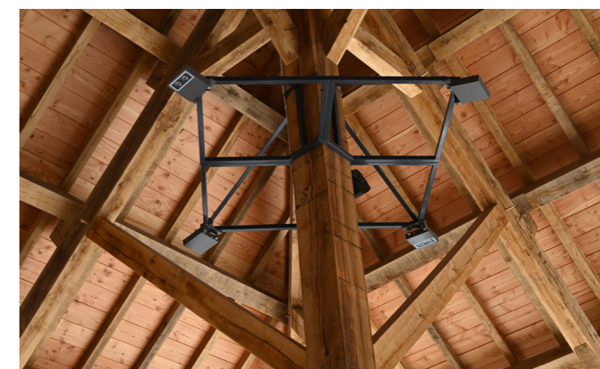
Aperçu de la charpente de la nouvelle halle de Sorges
